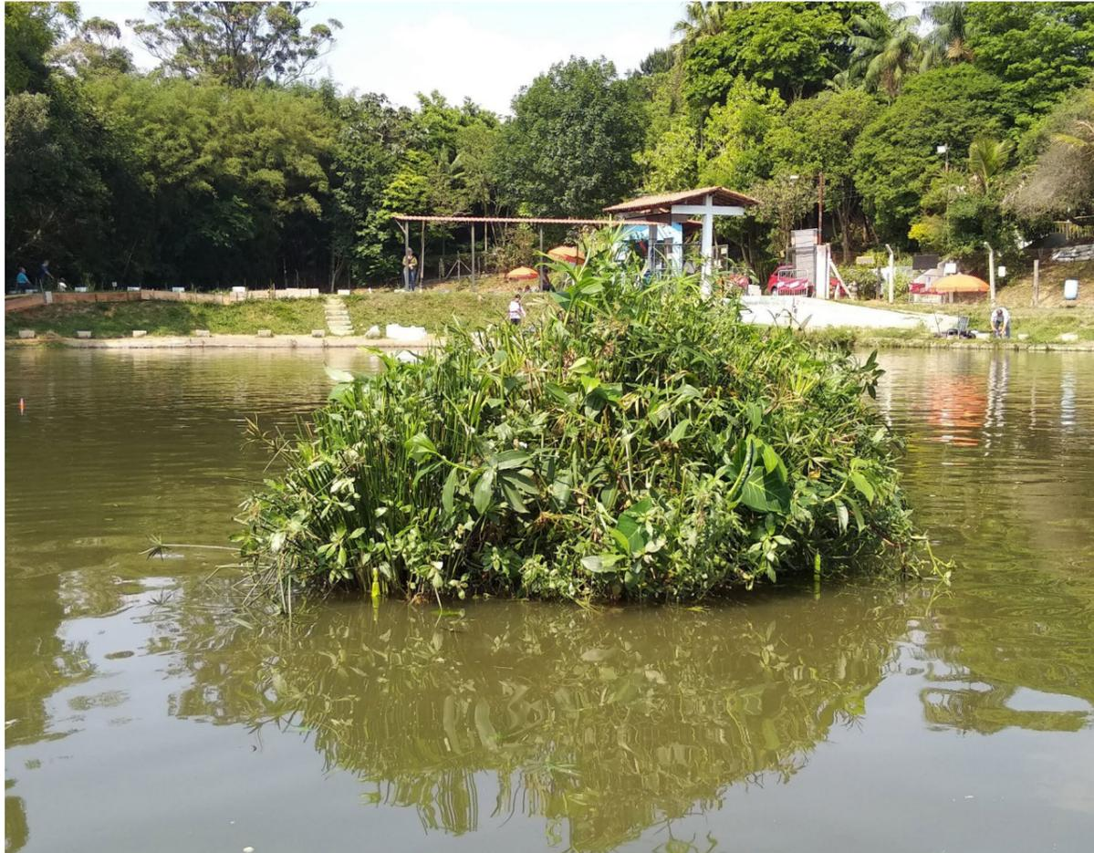
Figura 37 Ilha filtrante construída no Pesqueiro do Carmo, São Paulo/SP (Projeto de mestrado de Cleandho Marcos de Souza, 2020, foto: Cleandho Marcos de Souza, 2019).
