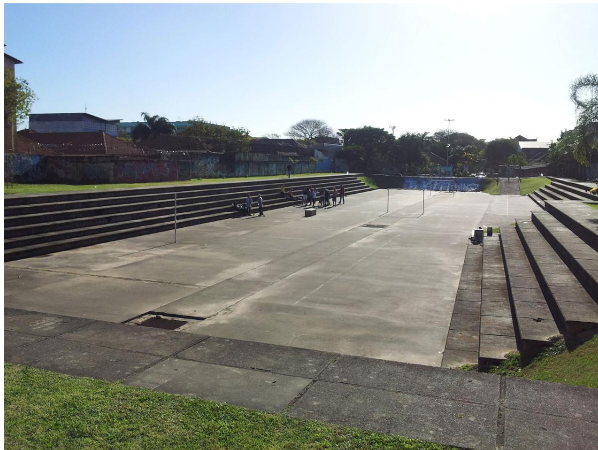
Figura 23 Reservatório de detenção em Porto Alegre com fundo impermeabilizado, quando há risco de contaminação de águas subterrâneas pelas cargas elevadas de poluentes (Foto: Erika Tominaga, 2023).
