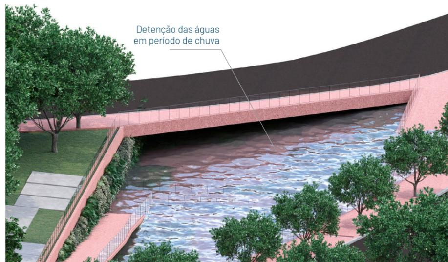
Figura 40 Reservatório anfíbio cheio, vista interna (Fonte: FCTH, 2021).
