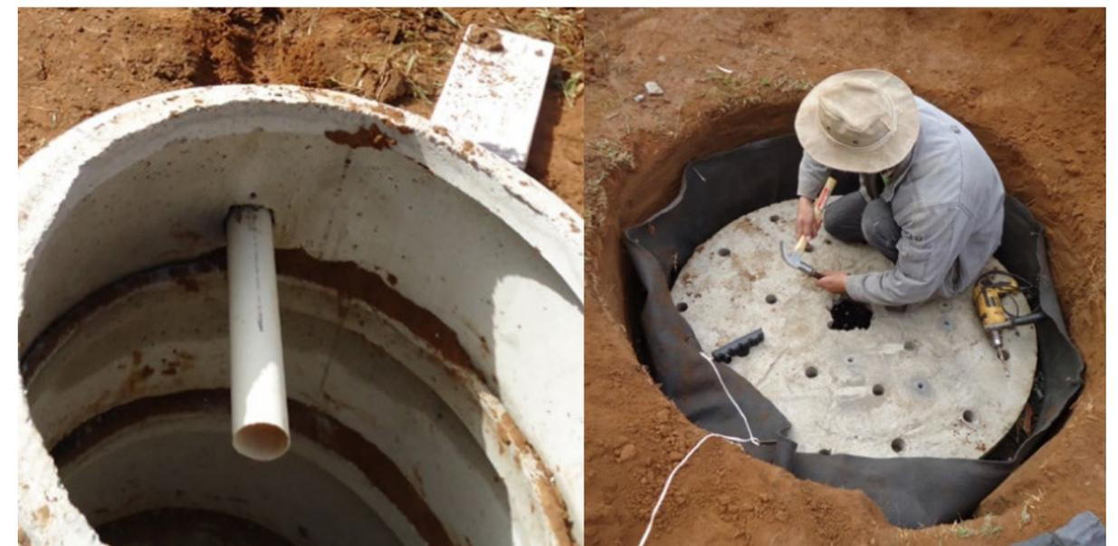
Figura 21 Poço de infiltração (Fonte: Thays Santos Ferreira, 2018).
