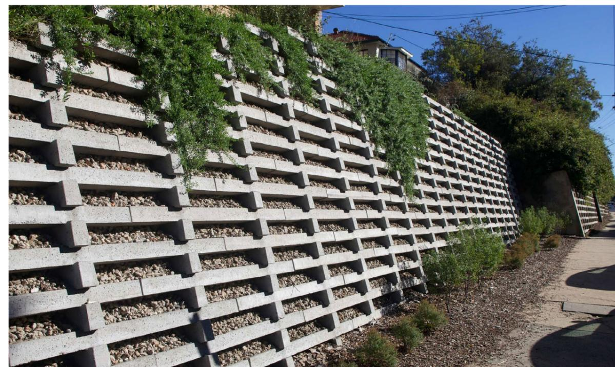
Figura 61 Muro de Suporte Tipo Cribwall Pré-moldado com Vegetação. Fonte: United Crib Blocks Constructions
