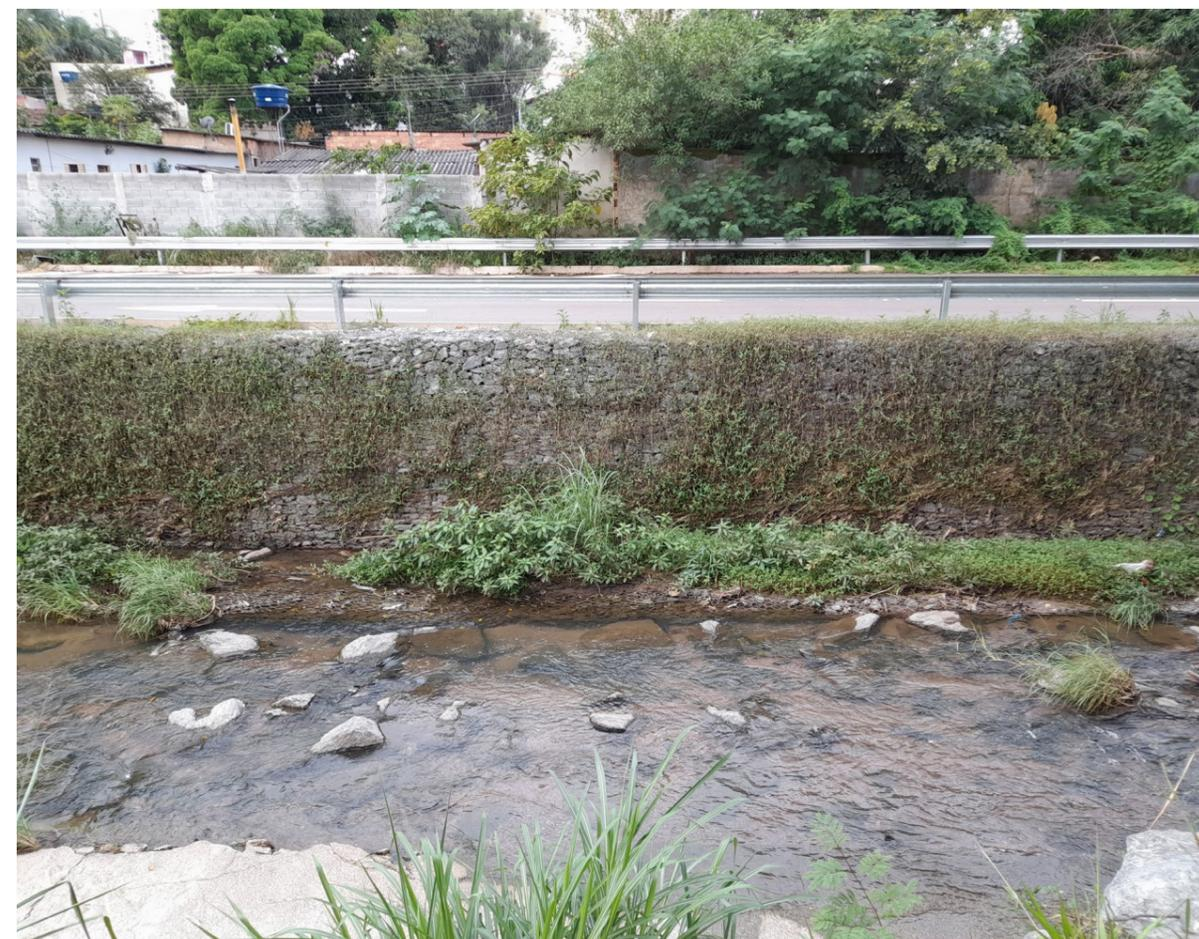
Figura 63 Muro de gabião com vegetação espontânea, Goiânia/GO (Acervo Belgo Soluções Geotech, foto: Flávio Fontes da Cruz, 2024).
