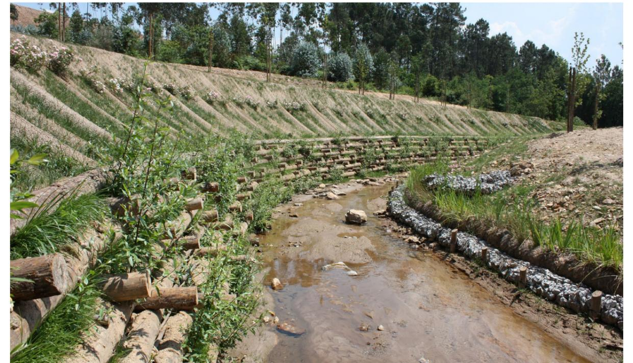
Figura 50 Na margem esquerda muro de suporte vivo parede dupla com plantio de arbustos autóctones e feixes vivos, biomanta de coco e hidrossemeadura e na direita gabião cilíndrico preenchido com pedra e biorretentor de coco vegetado, Ribeira de Gende, Portugal (Projeto Rita Sousa, foto: Rita Sousa, 2011).
